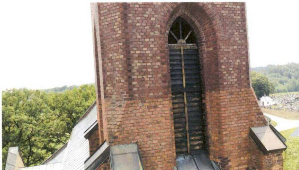
Widoczne oddzielenie kolorystyczne cegieł, z których wykonana jest wieża.
